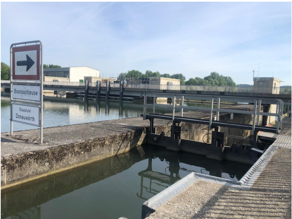
Schleuse und Wasserkraftwerk
